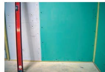
При монтаже листов АКУ-ЛАЙН используются саморезы 3,9x41 мм. Саморезы не должны попадать на виброузлы сэндвич-панелей. Шаг саморезов по вертикали составляет 200 мм, по горизонтали – 400 мм.
