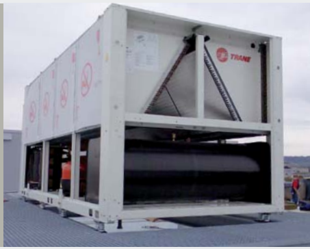
Специальная конструкция упругой опоры для холодильной машины
