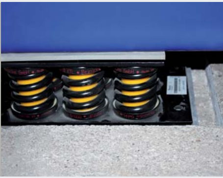
Пружинная виброизоляция блочных ТЭЦ
